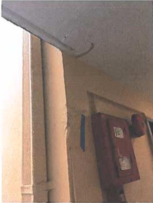
**3<sup>rd</sup> Floor Overhead Spall**
