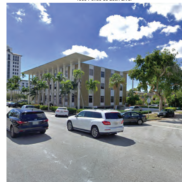
1000 Ponce de Leon Blvd.
