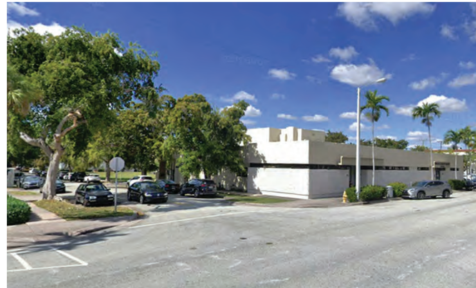
924 Ponce de Leon Blvd.
