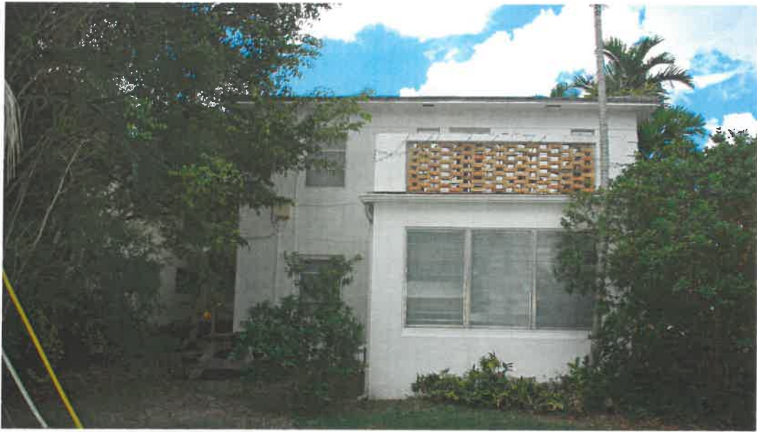
760 Valencia Ave - Side
