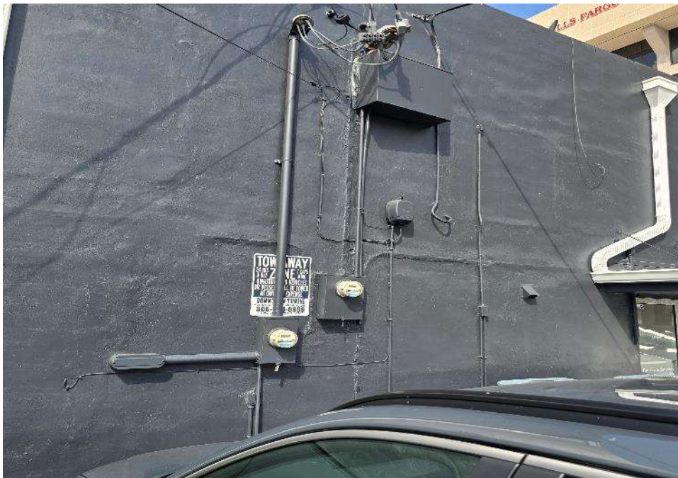
11.1 Service conduit raceways
