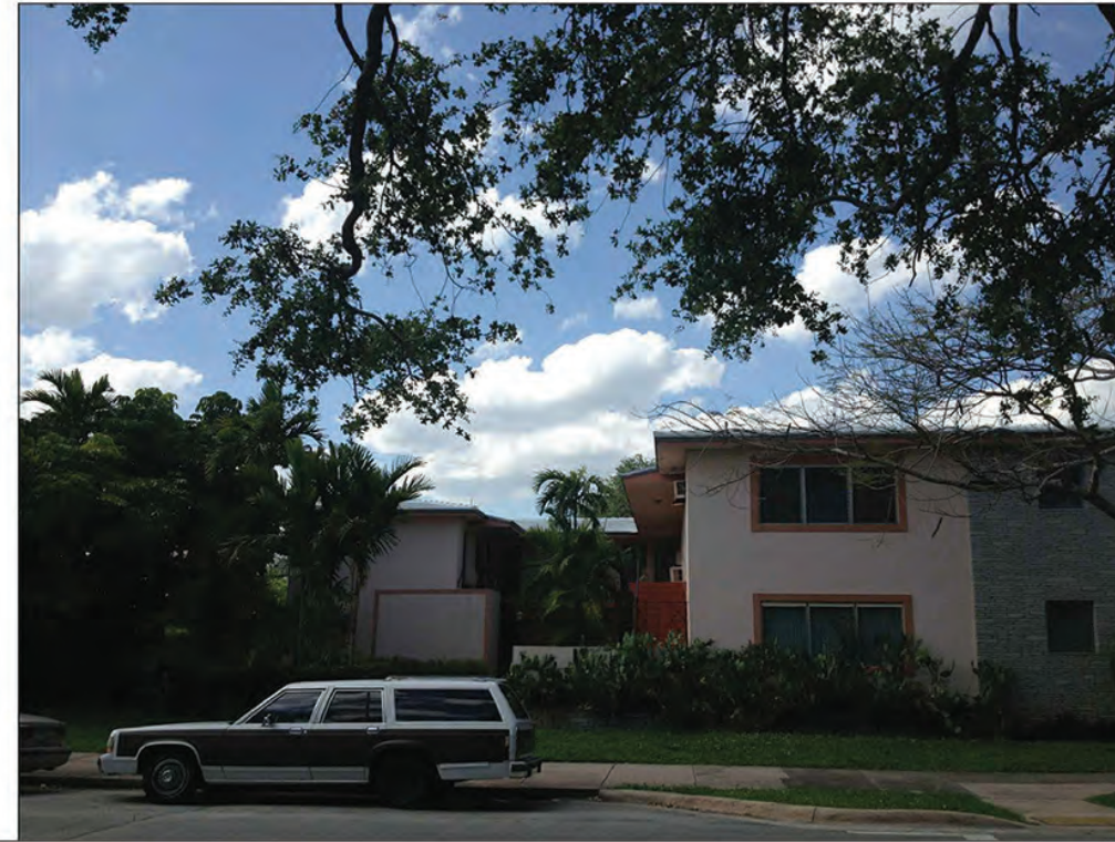
SITE PHOTO - 1 Scale: N. T. S.
