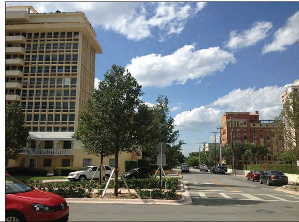
SITE PHOTO - 3 Scale: N. T. S.
