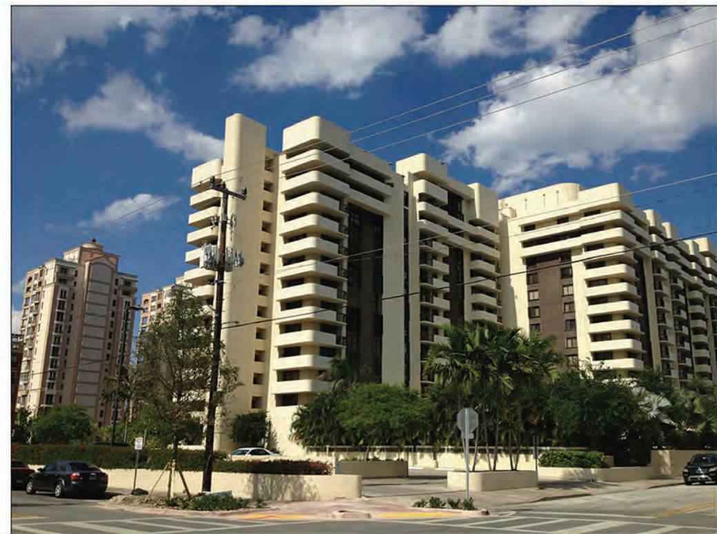
SITE PHOTO - 2 Scale: N. T. S.
