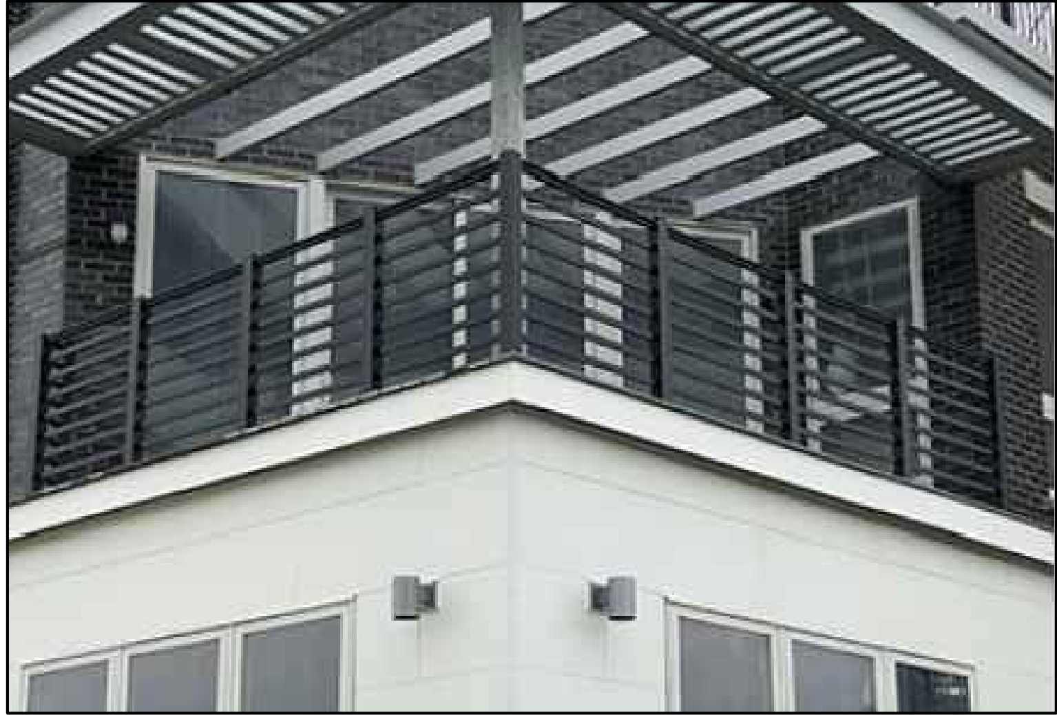
3. HORIZONTAL ALUMINUM RAILING 42" A.F.F.
