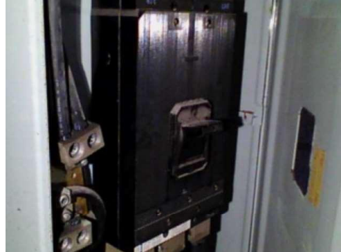
FLIR3784.jpg 3/05/2023 11:57:12 a. m.
