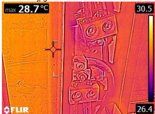
FLIR3781.jpg 3/05/2023 11:56:12 a. m.
