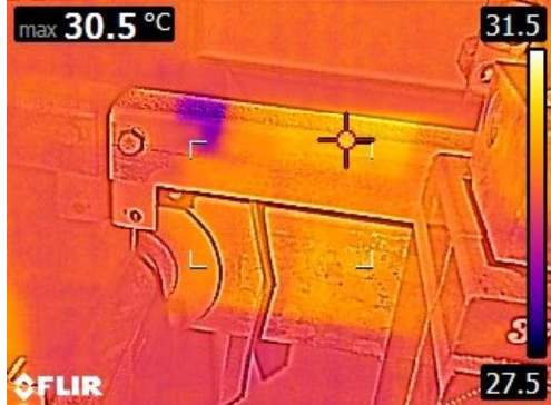
FLIR3776.jpg 3/05/2023 11:53:10 a. m.
