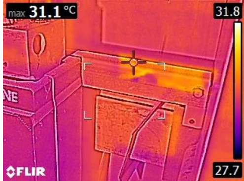
FLIR3775.jpg 3/05/2023 11:53:03 a. m.
