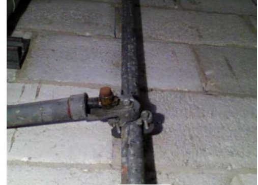
FLIR3777.jpg 3/05/2023 11:53:25 a. m.
