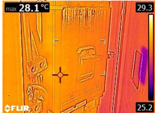
FLIR3784.jpg 3/05/2023 11:57:12 a. m.
