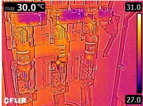
FLIR3779.jpg 3/05/2023 11:54:53 a. m.
