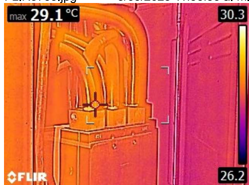
FLIR3783.jpg 3/05/2023 11:56:38 a. m.
