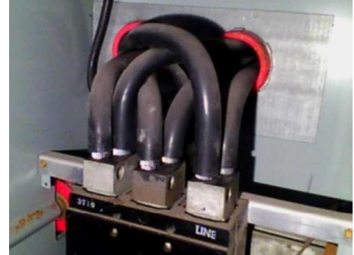
FLIR3774.jpg 3/05/2023 11:52:35 a. m.
