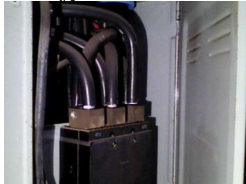
FLIR3783.jpg 3/05/2023 11:56:38 a. m.
