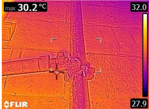
FLIR3777.jpg 3/05/2023 11:53:25 a. m.
