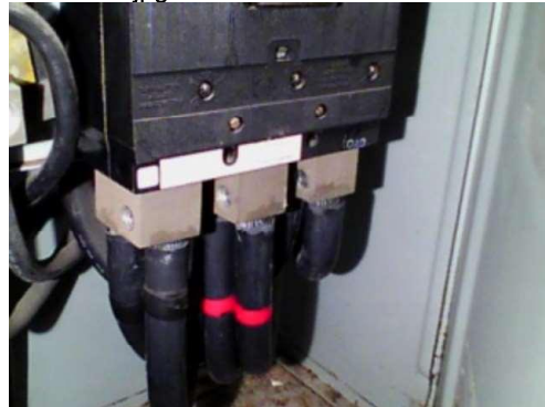
FLIR3782.jpg 3/05/2023 11:56:29 a. m.
