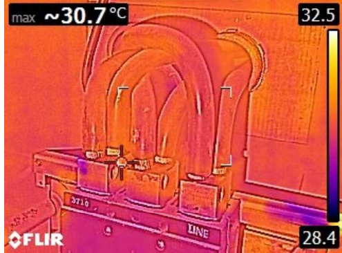
FLIR3774.jpg 3/05/2023 11:52:35 a. m.
