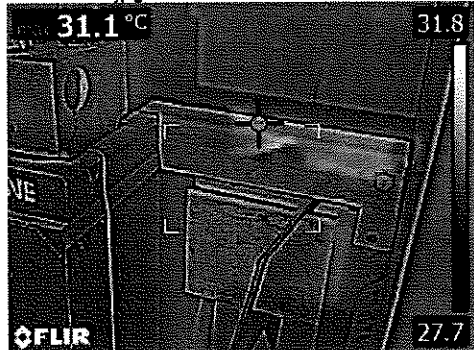
FLIR3775.jpg 3/05/2023 11:53:03 a. m.
