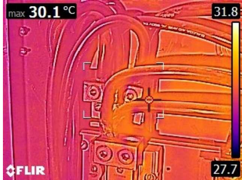
FLIR3778.jpg 3/05/2023 11:53:58 a. m.
