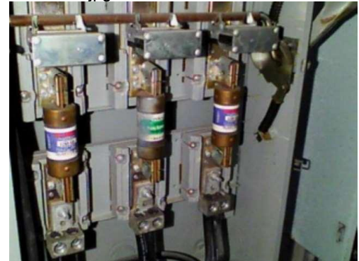
FLIR3779.jpg 3/05/2023 11:54:53 a. m.
