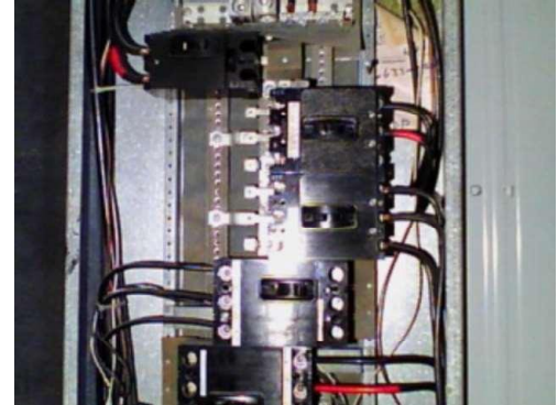
FLIR3786.jpg 3/05/2023 11:58:26 a. m.
